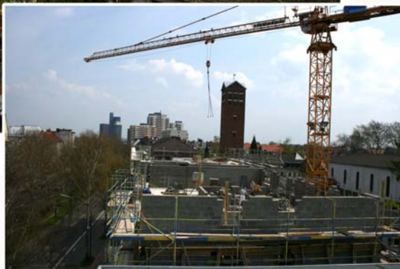
Baustelle Zollstockgürtel 33, April 2010
