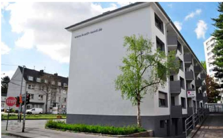
Außenwände sowie der Erneuerung der Fenster, der Hauseingangs- und Hoftüren. Diese Maßnahmen wurden durch eine Dämmung der Balkon- und Loggiaflächen ergänzt. Darüber hinaus wurde die energetische Sanierungsmaßnahme durch Instandhaltungsarbeiten wie die Erneuerung der Dacheindeckung, Kellertüren und einen Anstrich der Treppenhäuser, komplettiert.
