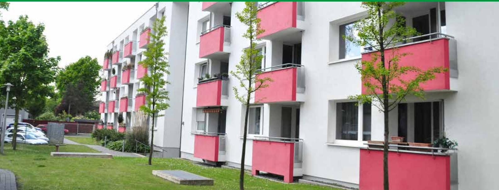
Kalscheurer Weg 43 Rückansicht
