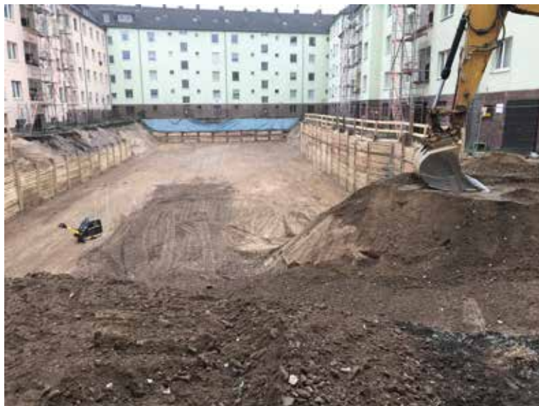
Zollstock-Karrees / Aushub für die zukünftige Tiefgarage
