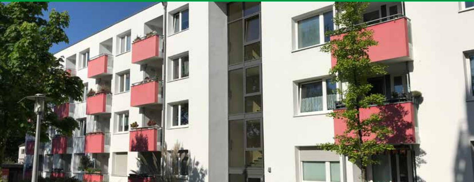
Kalscheurer Weg 43 (Rückansicht)
