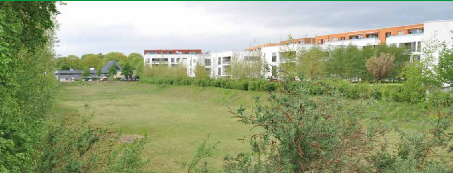
Vorgebirgsgärten - Baufeld III
