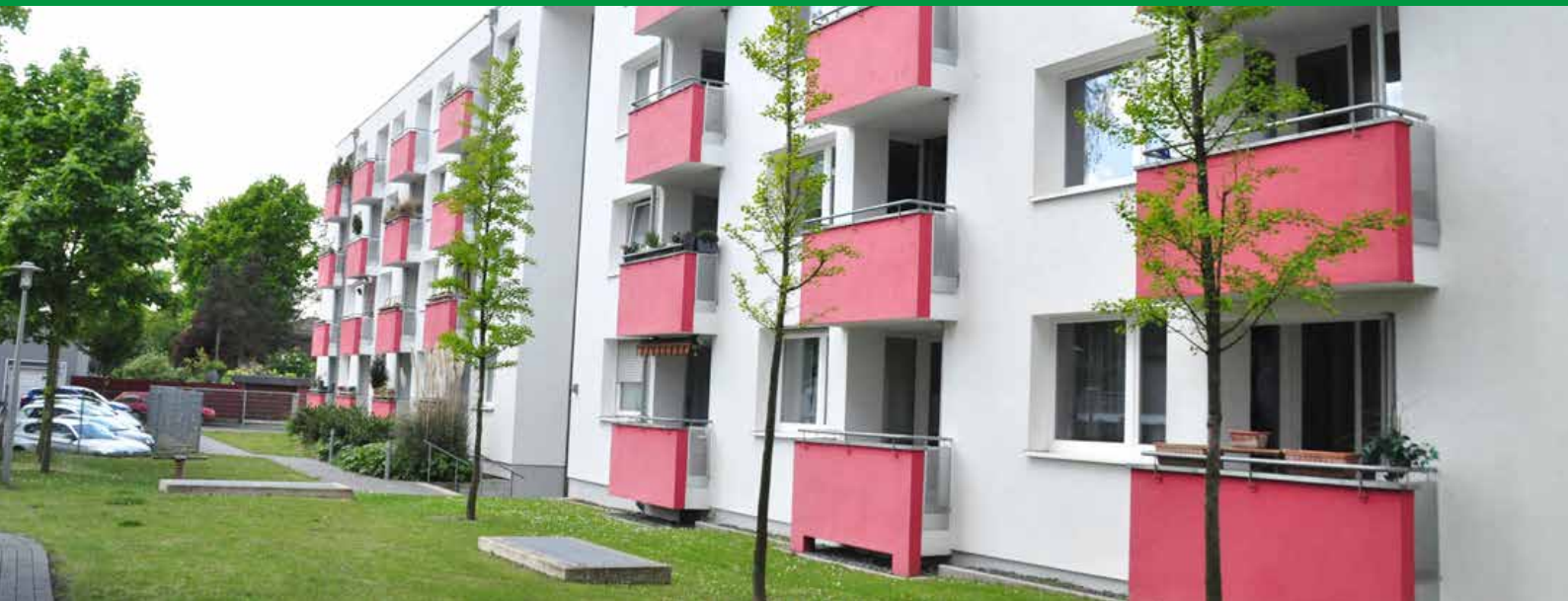
Kalscheurer Weg 43 Rückansicht
