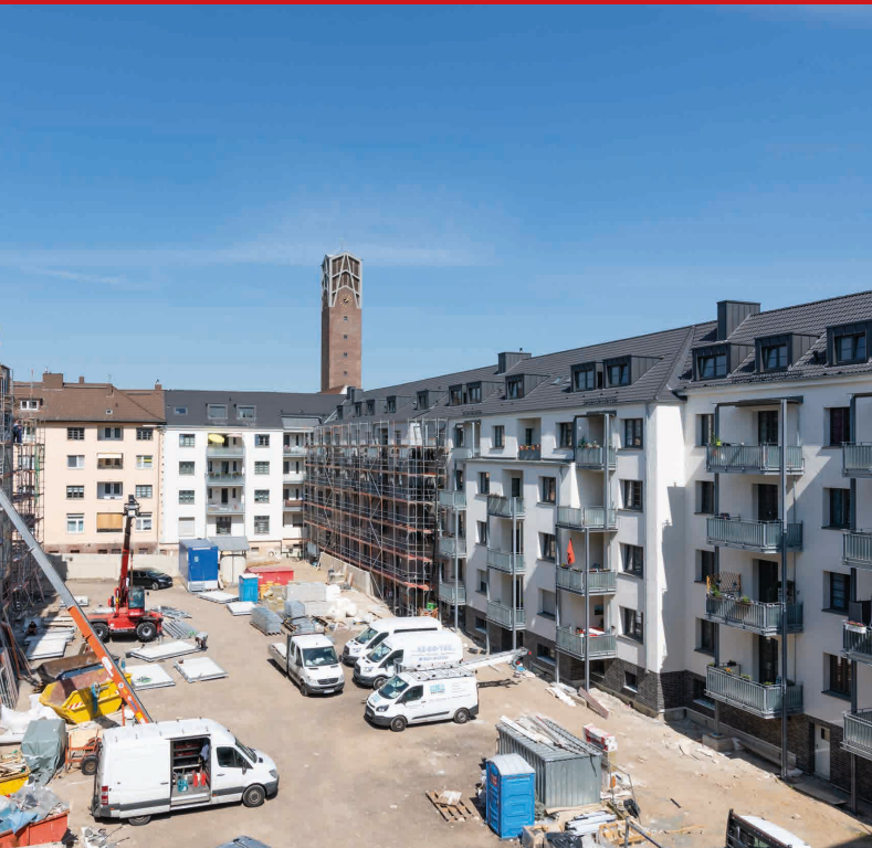
Zollstock-Karree Mitte (Baustelle Innenhof)
